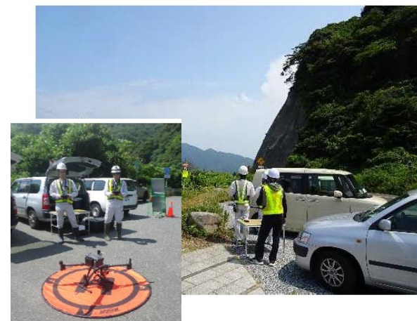
ドローン＋レーザー地形計測による法面点検 (国道178号 宮津市由良)
