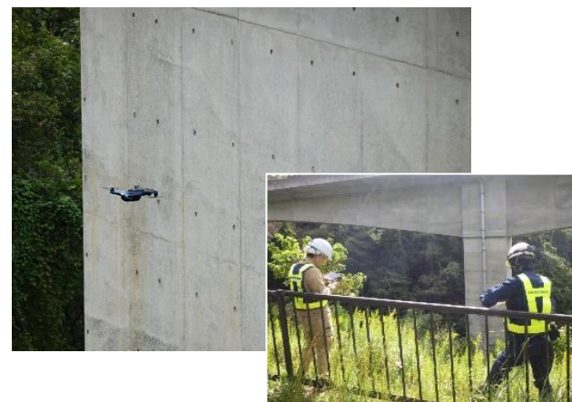
ドローン＋A I 画像解析による橋梁点検 (国道178号 伊根舟屋高架橋)
