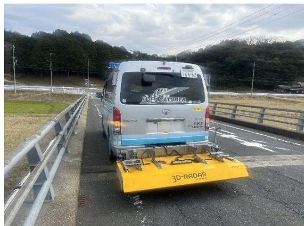
床板上面損傷判定システムを活用した 橋梁の床板点検 (国道482号 国久橋)
