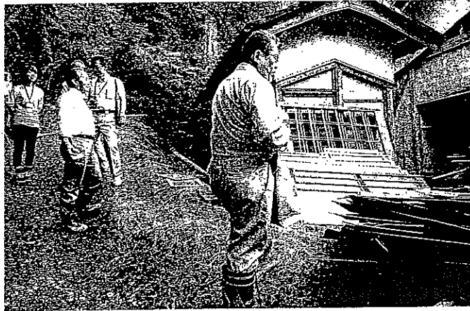
トイレの建設地を見学(光明寺庫裏下)
