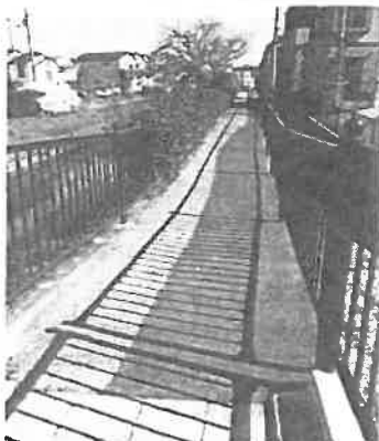
有栖川六反田橋堤防改修と転落防止策設置
