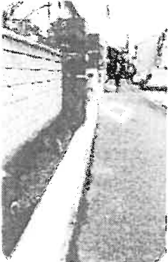
常盤野学区下立売通（西町付近）側溝の改修と、丸太町通の歩道の側溝の溝蓋の方々つきについて、側溝に筒所30メートルについて、隙間に木を挿入するなど当面の改修を完了。
