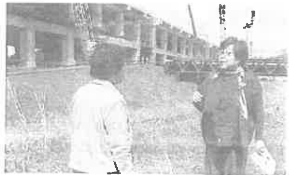
北陸新幹線敦賀駅工事を調査(3月14日)
