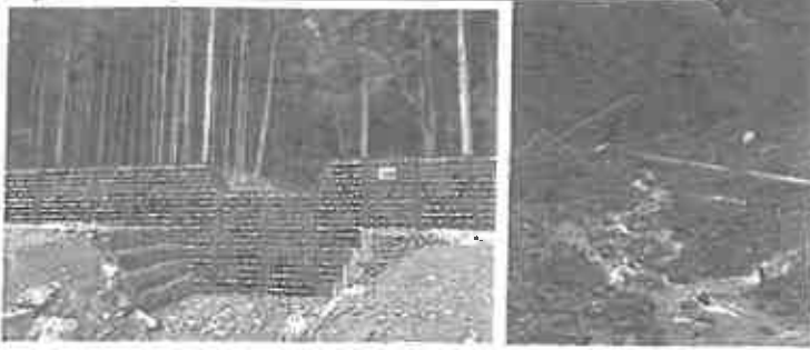
▲第一期工事完成
