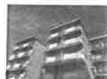
鳩のフン害防止ネットも張られている向日台団地
