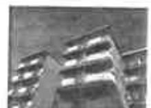
鳩のフン害防止ネットも張られている向日台団地
