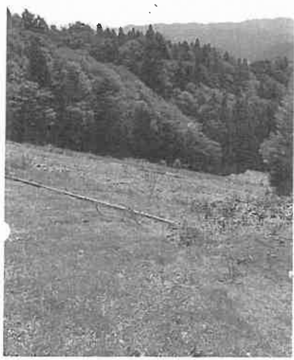
小塩川上流域の広域森林林道改修工事箇所で しょうか。起点から51mの高さにのぼる盛 り土である表示もありました。
