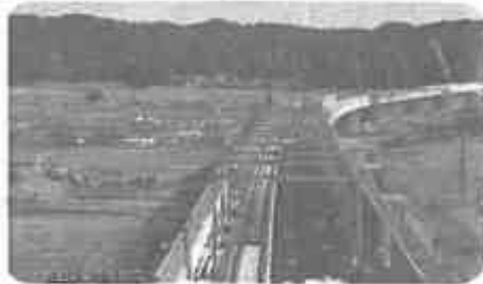
金沢一教資で進む建設工事。鉄道運輸機構HPより
