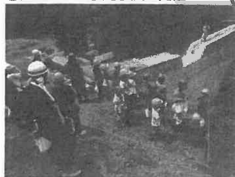
治山ダム工事現場見学会（多門院小字黒部地区）
