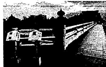
新しくなった三条大橋
