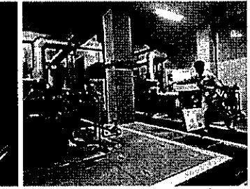
新荒河排水場（治水対策）
