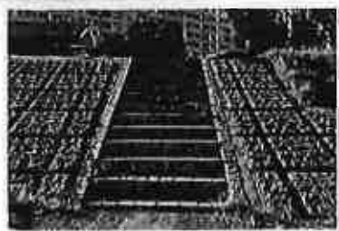
▶ 鴨川の河川敷の階段に手すりを — 京都土木事務所へ要望
