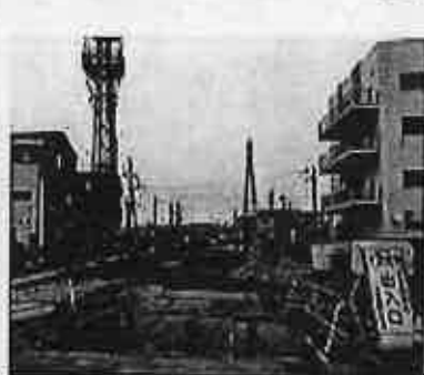
▲向日町駅から国道171号へつなげ拡幅する府道工事現場（都市計画道路）
