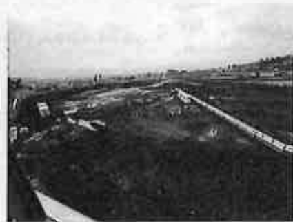
競輪場 工事現場
