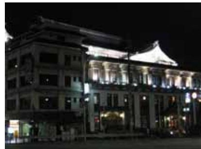
特定照明（建築物へのライトアップ）
