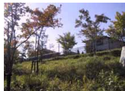
法面への緑化事例
