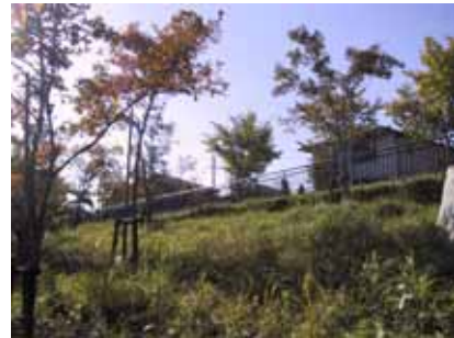
法面への緑化事例
