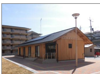
府営住宅等における 木質化等の例（集会所）
