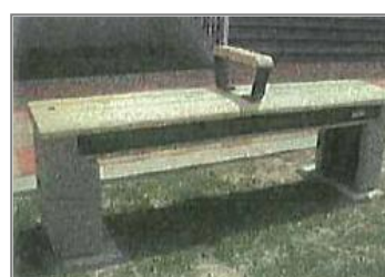
府営住宅等における 災害対策の例（かまどベンチ）
