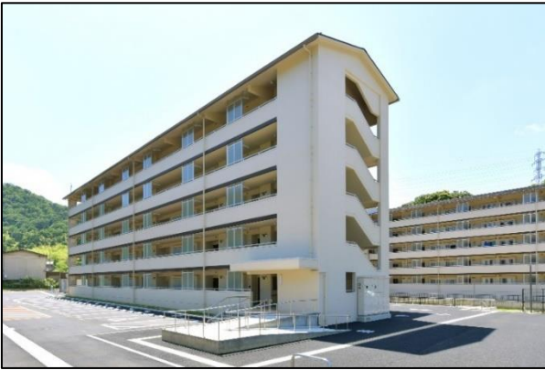
【写真－3 鉄筋コンクリート造5階建ての事例】
