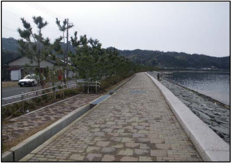
宮津港海岸 矢原地区 ふるさと海岸整備
