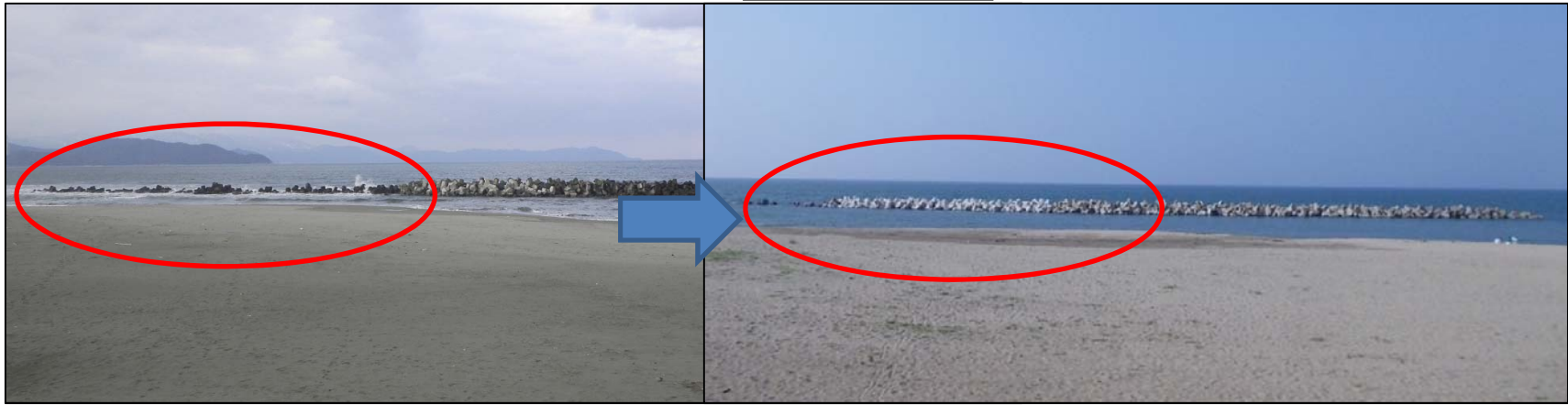
神崎海岸 沈下した離岸堤を計画高まで再設置により補修
