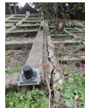
・地山の緩み(擁壁工のクラック)
