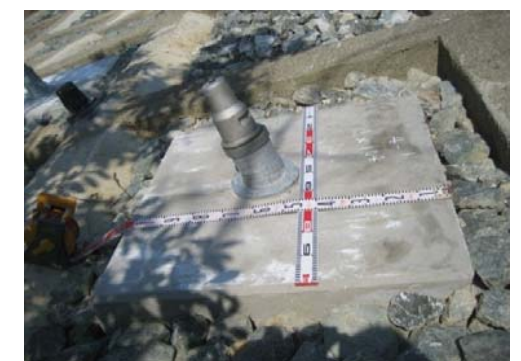
・斜面の安定を図るため、法枠内に 鉄筋挿入工を設置
