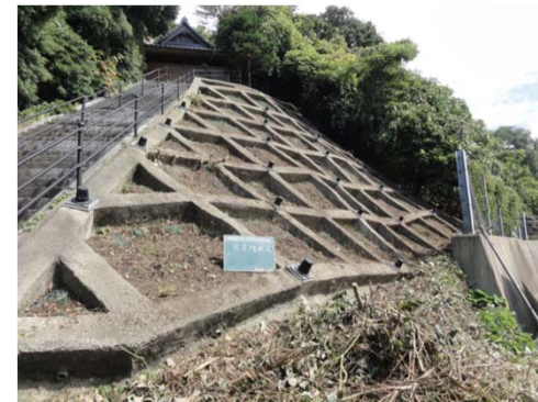
・地山の緩み(グラウンドアンカーの緩み)
