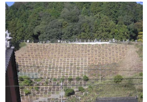
・斜面の安定を図るため、法枠内に 鉄筋挿入工を設置
