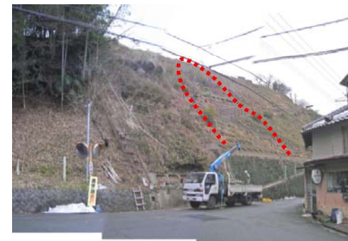
・地山の緩み(擁壁工のクラック)
