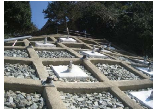
・斜面の安定を図るため、法枠内に グラウンドアンカーを設置
