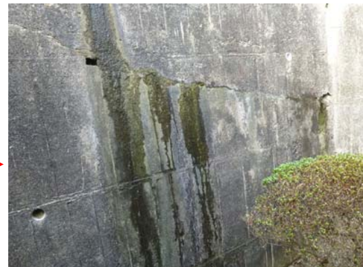
・擁壁にクラック、漏水が発生
