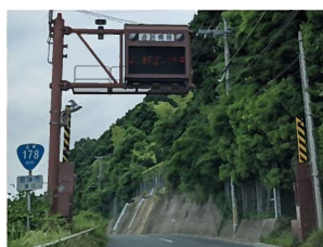
【写真-2 現況道路 (通行規制ゲート)】
