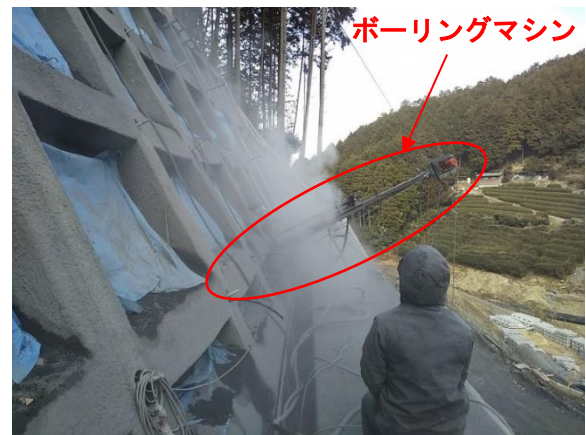
無足場工法によるボーリングマシンでの削孔状況 (中ノ谷川)
