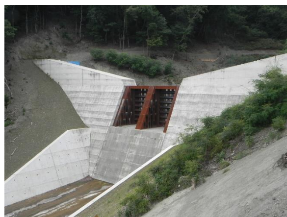
部分透過型堰堤 (施工例)
