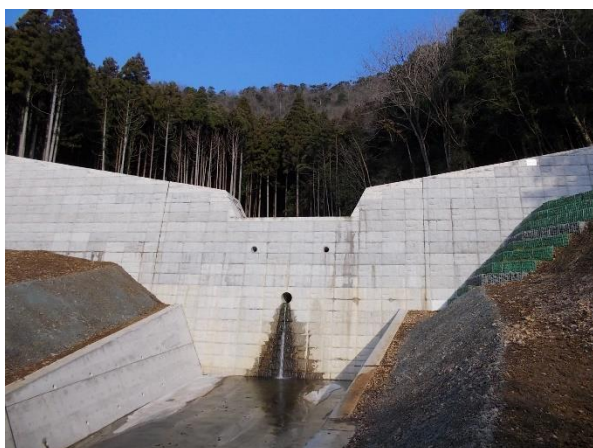
不透過型堰堤 (施工例)
