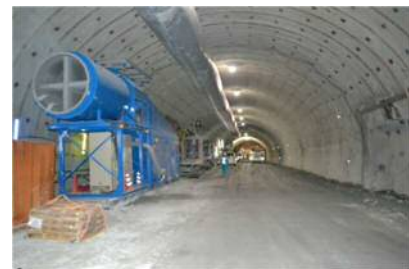
【写真-6 集じん機の例】
