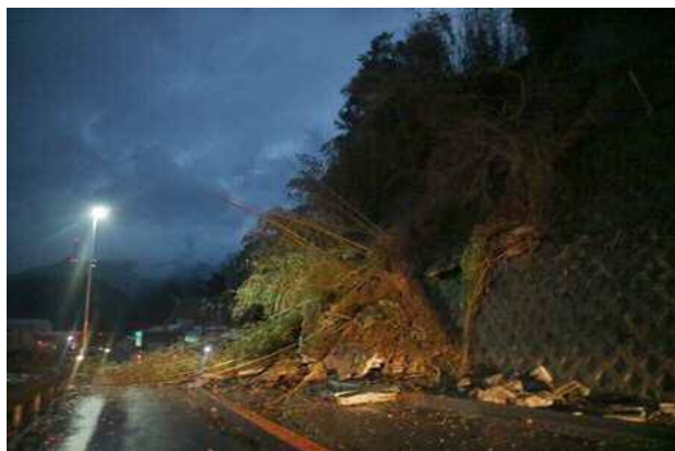
【写真-4 国道9号被災状況（H31. 1）】
