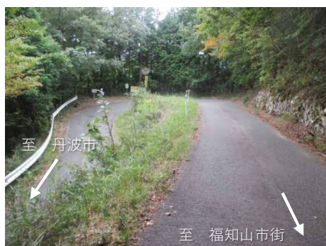
【写真-1 ヘアピンカーブ箇所】
