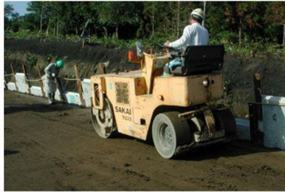
④内部材の敷均し、締固め
