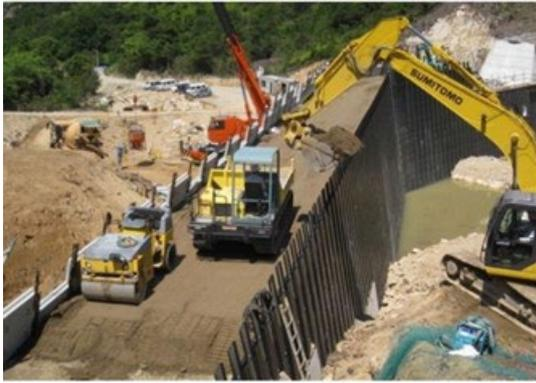
③内部材の投入(バックホウによる投入の例)
