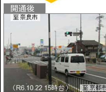
写真-3 開通前後の交通状況 (木津交差点付近)
