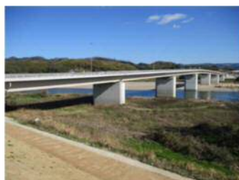
写真-6 木津川橋（ベージュ系塗装）
