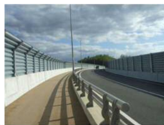
写真-7 歩道舗装（脱色アスファルト）
