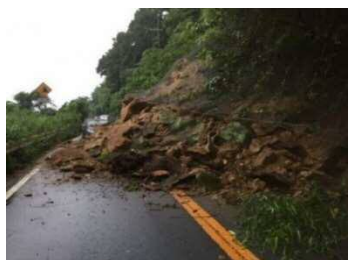
写真-5 国道163号落石・崩土
