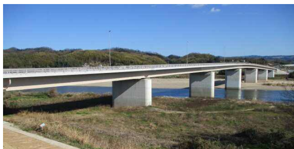
写真-1 木津川橋
