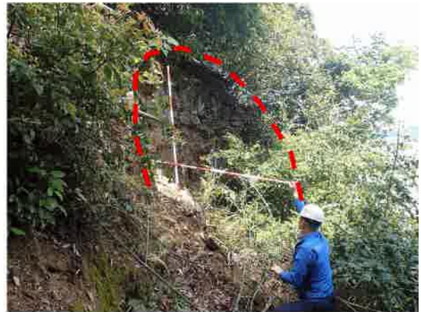
NO. 10～NO. 11 付近。奥行 1.5m 程度の岩盤の抜け落ちが確認された。
