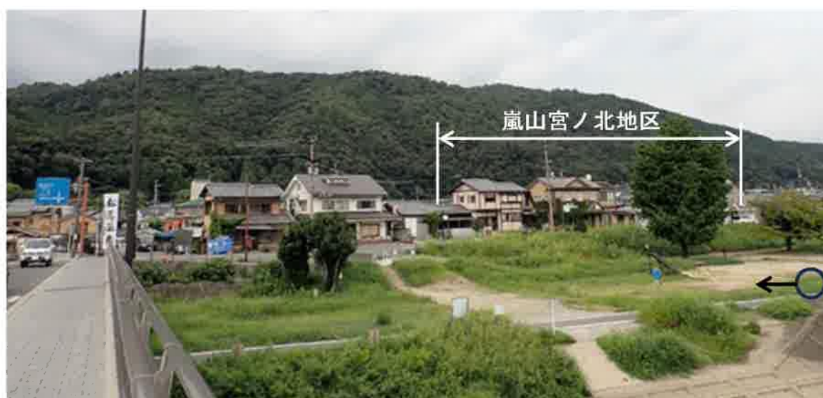
写真- 1 事業箇所全景写真
