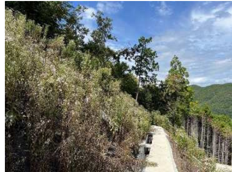
図-20 本事業で実施した在来種による法面緑化
