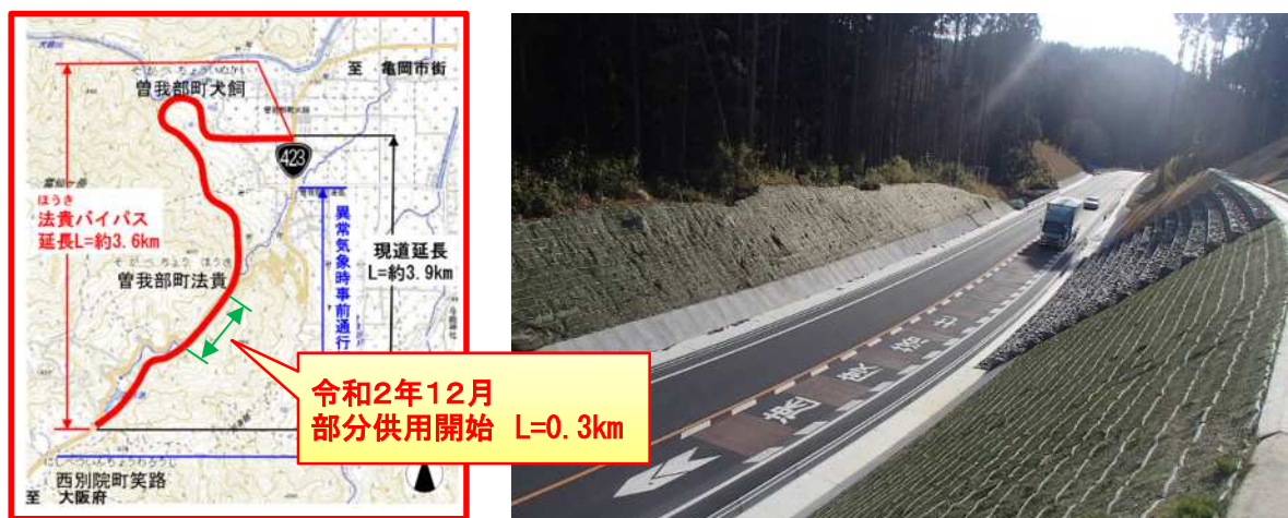
図-11 部分供用の状況
