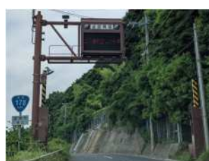
【写真-2 現況道路 (通行規制ゲート)】
