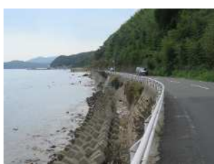
【写真-1 現況道路】
