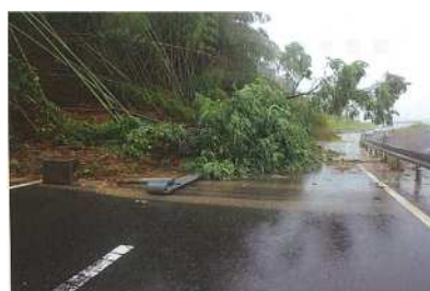
【写真-4 山側崩壊 (H30. 7. 7 連続雨量 439mm)】
