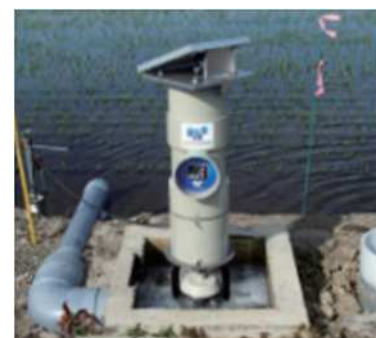
写真-6 自動給水栓
