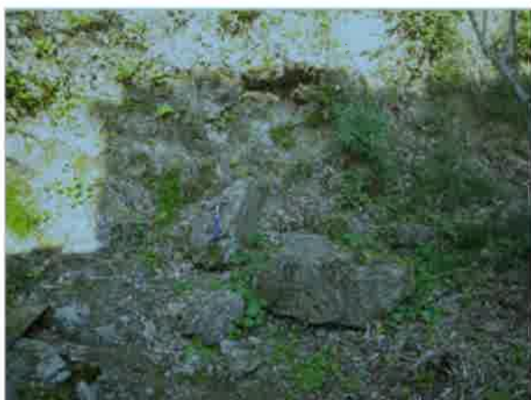
【写真番号⑰】 露岩状況 (8No.4 付近)
