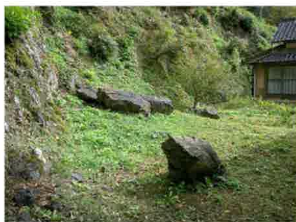
【写真番号⑯】 落石状況 (2No.0+5.0 付近)
