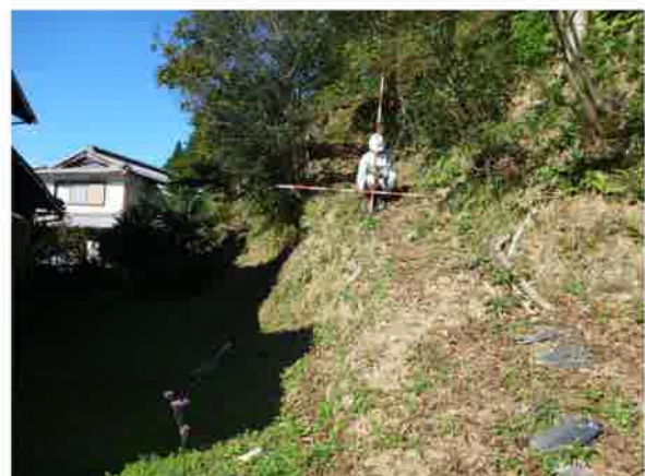
【写真番号⑫】 3No.4 付近の状況
