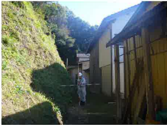
【写真番号⑦】 1No.1+10 付近の状況
