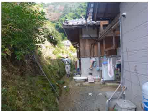
【写真番号⑨】 2No.3+10 付近の状況
