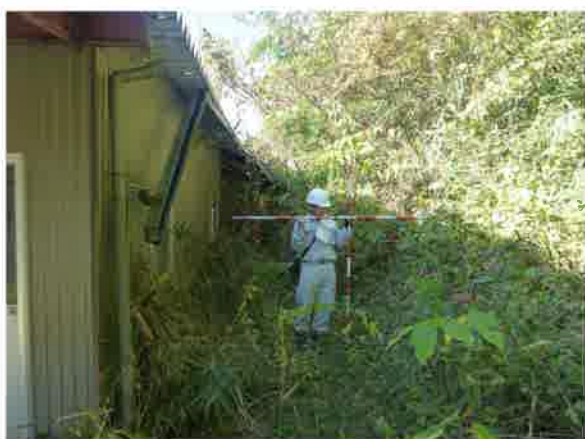
【写真番号⑬】 6No.2+5.0 付近の状況
