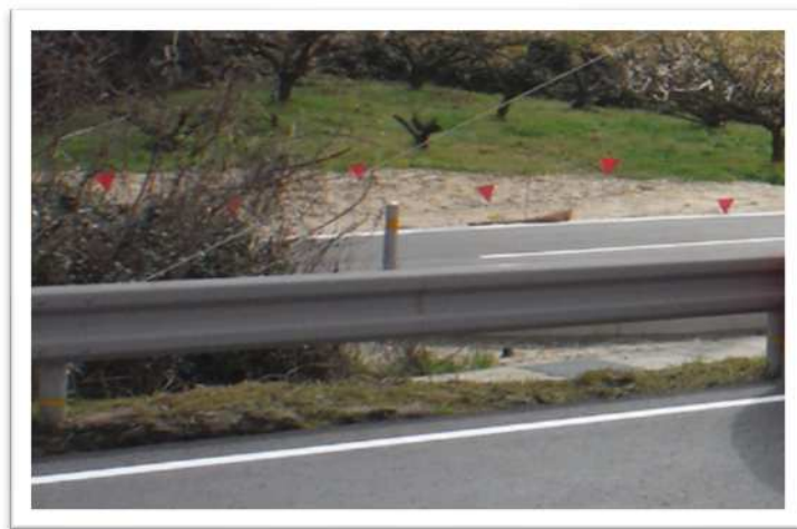
【写真-5 隣接工区での設置状況】
