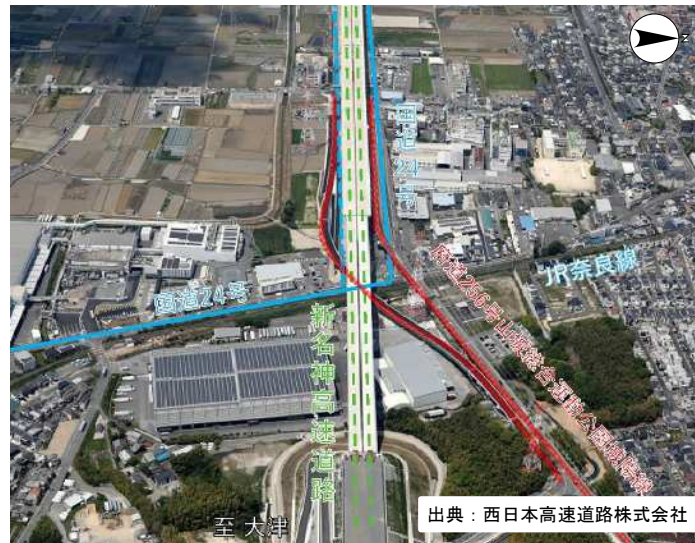
【写真-2 城陽橋付近の整備状況】
