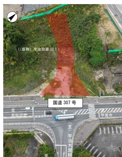
【写真－１ 国道 307 号の状況】
