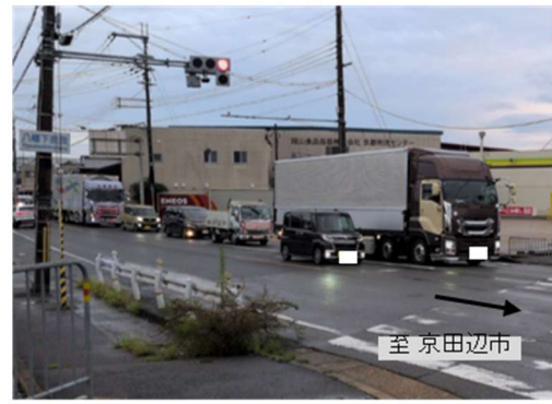
写真-4 府道八幡木津線(八幡下奈良交差点)の状況
