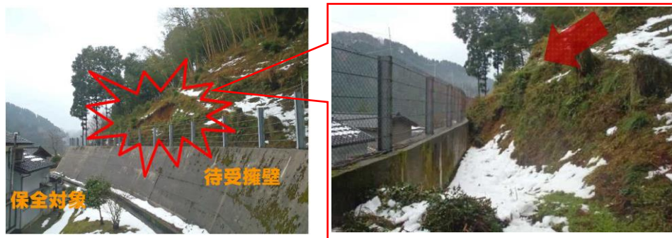
図 待受擁壁により崩壊土砂を捕捉した事例
