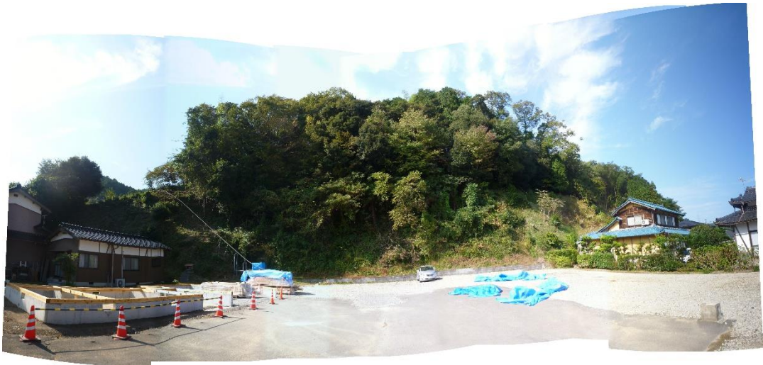
【写真番号⑩】 測点 NO. 23～NO. 26 付近の状況
