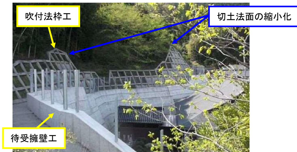
急傾斜地崩壊対策工 施工事例(志高地区 第1工区)
