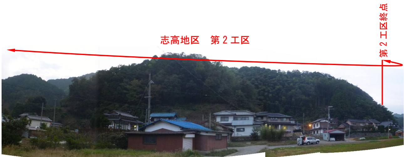
【写真番号③】 志高地区 第2工区 全景写真（終点側を望む）
