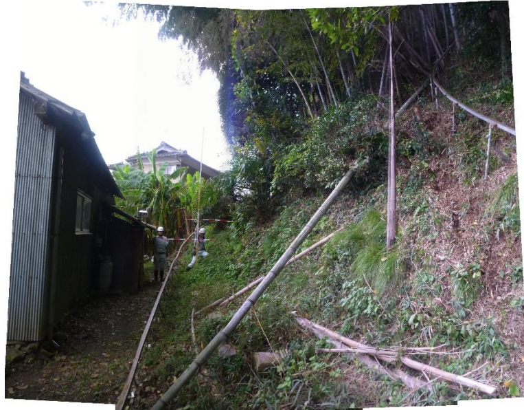
【写真番号⑯】 測点 NO. 43 付近の状況
