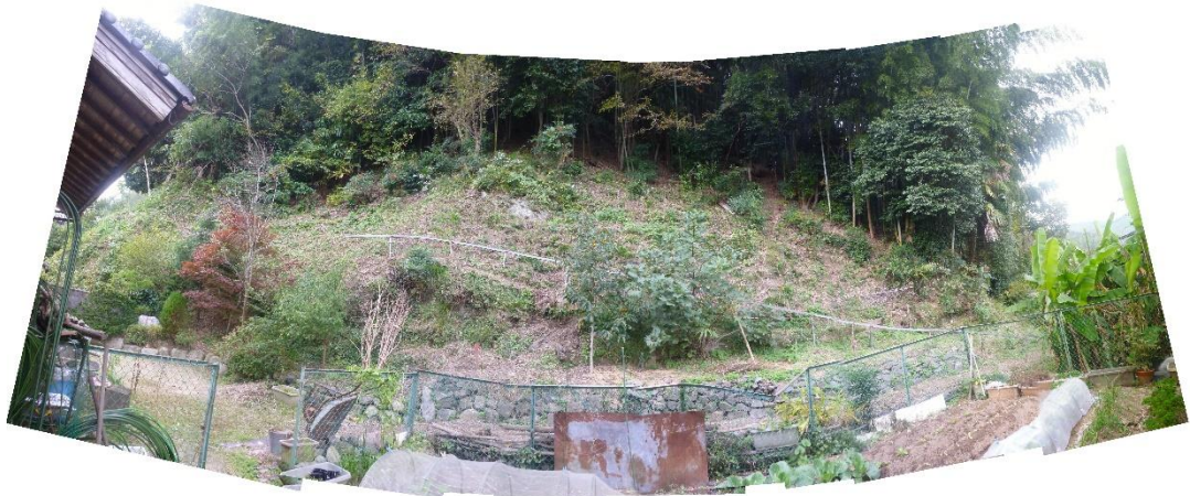
【写真番号⑬】 測点 NO. 40～NO. 42 付近の状況
