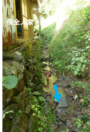
【写真番号⑤】 NO. 3 付近の状況
