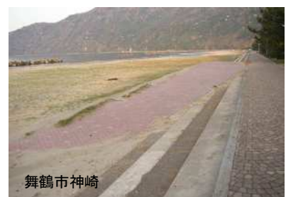
図 1-5-14 スロープの整備
