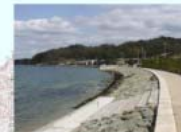
矢原周辺 護岸整備が進み、親水性護岸、階段、散策路などが整備されている。
