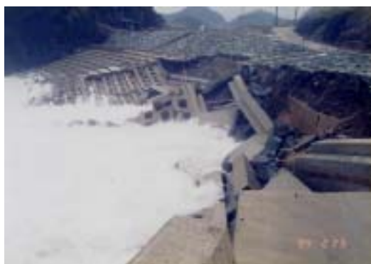
冬季風浪による海岸保全施設の被災
