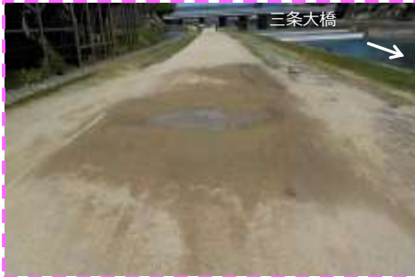
三条大橋～四条大橋 〈環境整備〉園路舗装の補修 [検討中]
