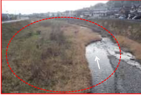
賀茂川通学路橋～庄田橋 〈治水対策〉堆積土砂の撤去
