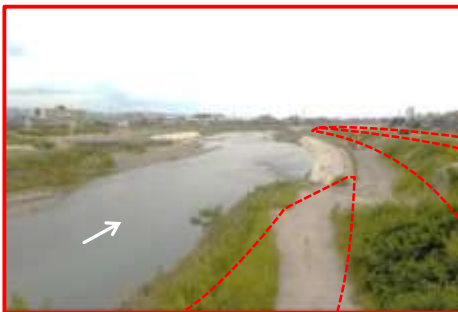
京川橋下流 右岸 〈治水対策〉護岸整備
