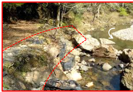
〈治水対策〉護岸修繕 高野川:八瀬小学校対岸
