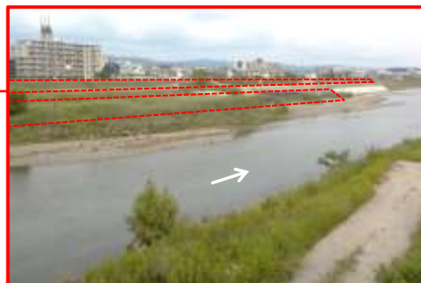
京川橋下流 左岸 〈治水対策〉護岸整備
