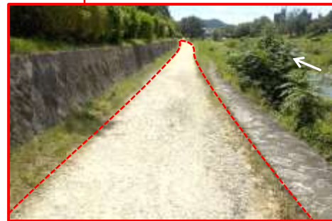
出町橋～北大路橋 左岸 〈環境整備〉園路舗装の補修
