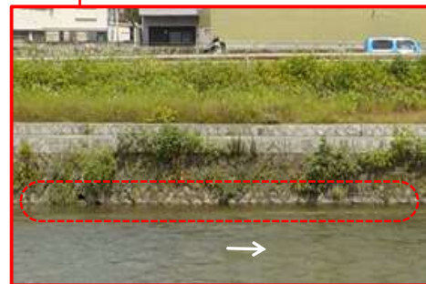
塩小路橋下流 左岸 〈治水対策〉護岸補修(根継工)
