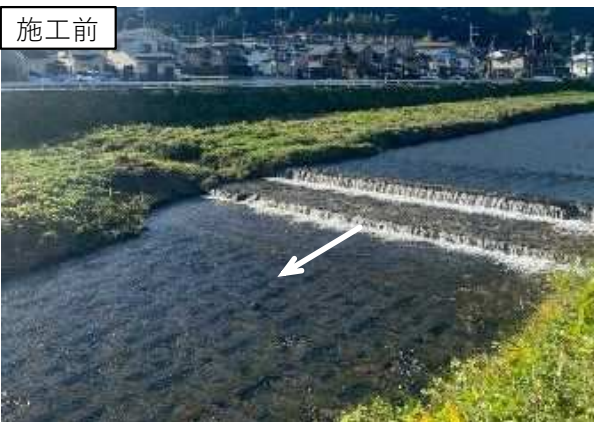
志久呂橋下流
