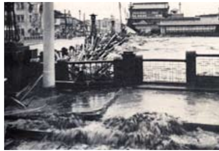
四条大橋付近のはん濫状況 出典:昭和10年6月29日水害写真(京都府)
