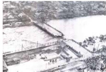
三条大橋の流出状況 出典:昭和10年6月29日水害写真(京都府)
