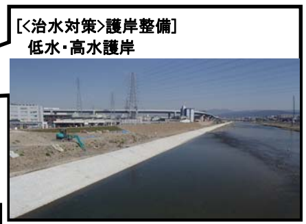
(勸進橋下流右岸)
