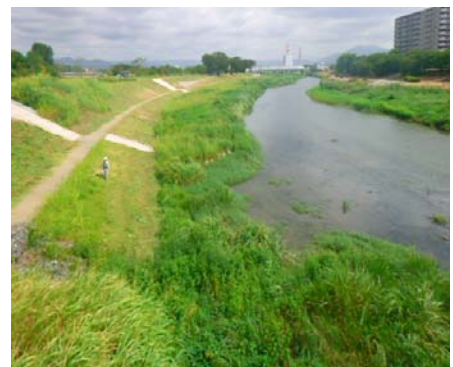
水とのふれあい回廊（京川橋上流）
