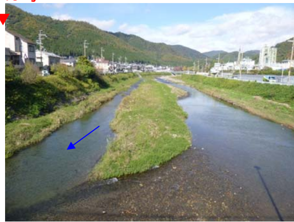
2013 年 11 月 14 日 （施工後 約 2 年 8 ヶ月・18 号出水後）
