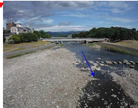
2013 年 10 月 11 日 (施工後 約 3 年 7 ヶ月・18 号出水後)
