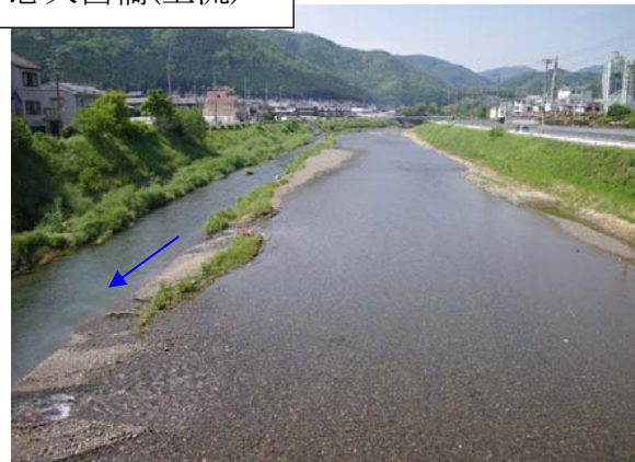
2011 年 5 月（施工後 約 2 ヶ月）
