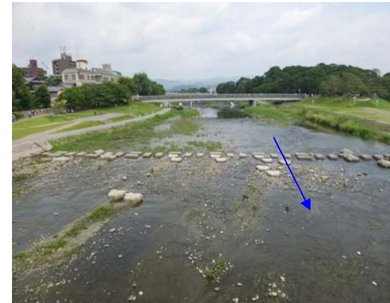
2014 年 7 月 17 日 (施工後約 4 ヶ月)
