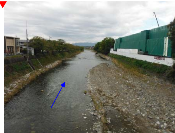
2013 年 10 月 11 日 (施工後 約 1 年 7 ヶ月・18 号出水後)
