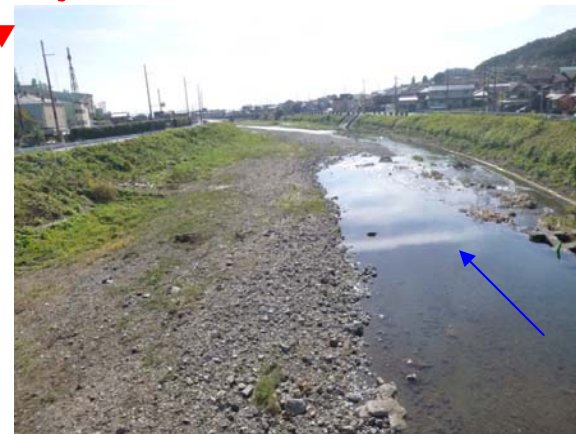
2013 年 11 月 14 日 （施工後 約 2 年 7 ヶ月・18 号出水後）
