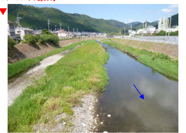
2014 年 9 月 22 日（施工後約 3 年 4 ヶ月） （H26 台風 11 号後 約 1 ヶ月）
