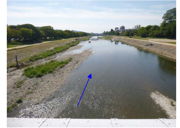
2014 年 9 月 22 日（施工後約 3 年 6 ヶ月） （H26 台風 11 号後 約 1 ヶ月）
