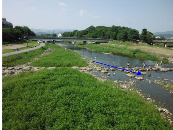
2013 年 8 月 14 日 (施工後 約 3 年 5 ヶ月・出水前)
