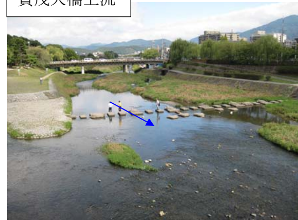
2009 年 10 月 1 日 (施工前)
