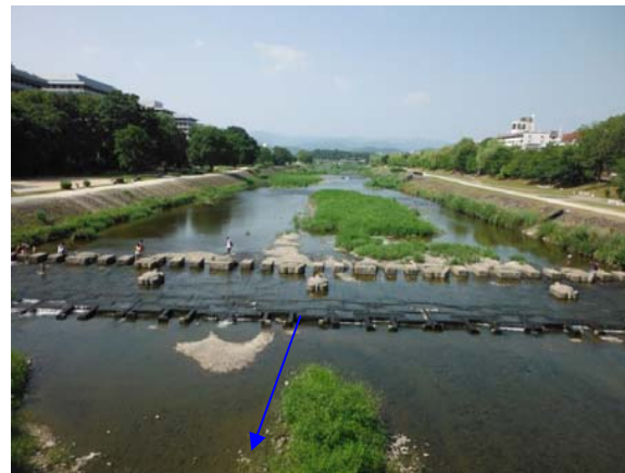
2013 年 8 月 14 日 （施工後 約 2 年 5 ヶ月・18 号出水前）
