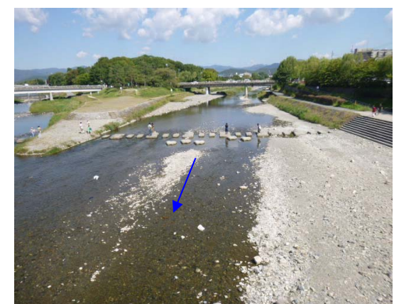
2014 年 9 月 22 日 (施工後約 6 ヶ月) (H26 台風 11 号後 約 1 ヶ月)
