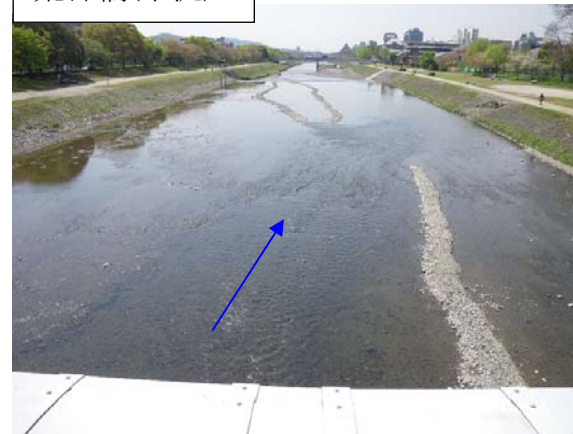
2011 年 4 月（施工直後）
