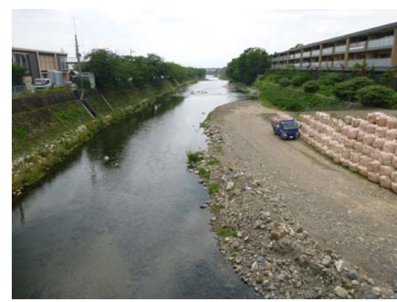
2014 年 7 月 17 日 (施工後約 2 年 4 ヶ月) (H25 台風 18 号後 約 10 ヶ月) 上流左岸で護岸工事を施工中
