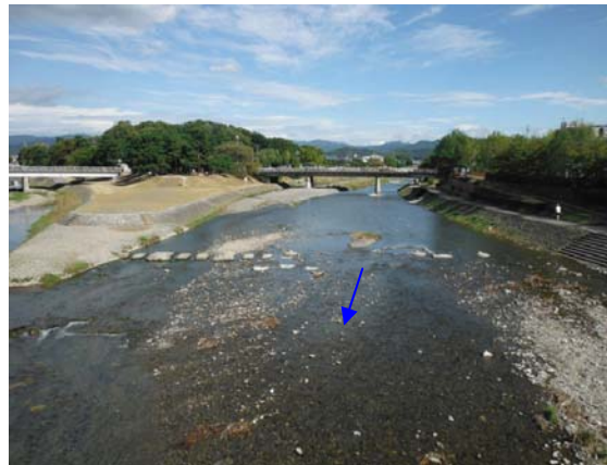
2013 年 10 月 11 日 (施工後 約 3 年 7 ヶ月・出水後)
