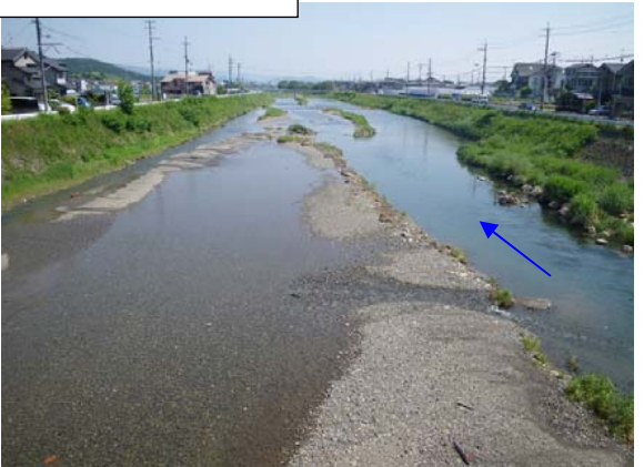
2011 年 5 月（施工後 約 2 ヶ月）
