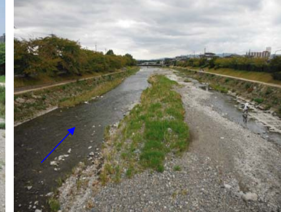
2013 年 10 月 11 日 （施工後 約 3 年 7 ヶ月・18 号出水後）
