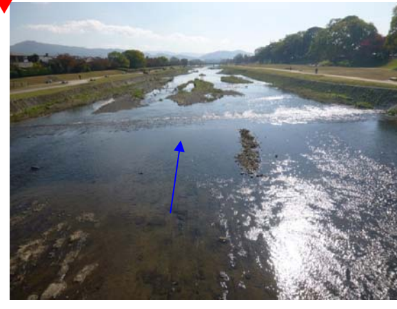
2013 年 11 月 14 日 （施工後 約 1 年 8 ヶ月・18 号出水後）
