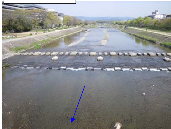
2011 年 4 月（施工直後）
