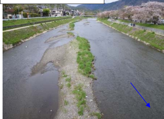
2010 年 4 月 16 日（施工直後）
