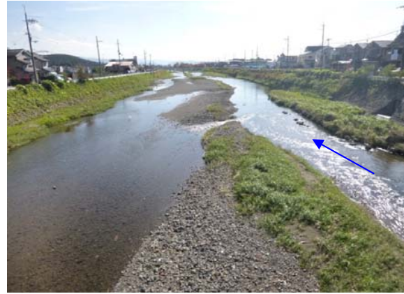
2013 年 11 月 14 日 （施工後 約 2 年 8 ヶ月・18 号出水後）
