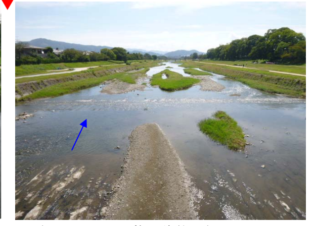
2014 年 9 月 22 日（施工後約 2 年 6 ヶ月） （H26 台風 11 号後 約 1 ヶ月）
