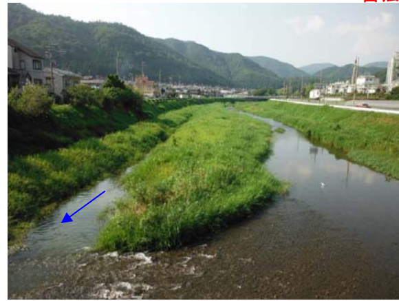
2013 年 8 月 14 日 （施工後 約 2 年 5 ヶ月・出水前）
