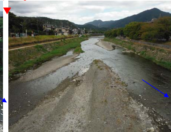
2013 年 10 月 11 日 （施工後 約 3 年 7 ヶ月・18 号出水後）
