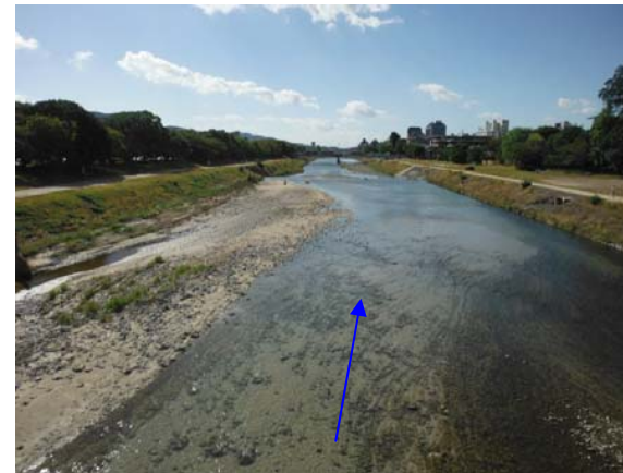
2013 年 10 月 11 日 （施工後 約 2 年 7 ヶ月・18 号出水後）
