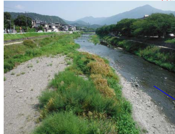
2013 年 8 月 14 日 （施工後 約 3 年 5 ヶ月・18 号出水前）
