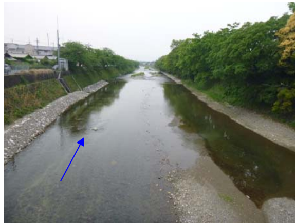
2012 年 5 月 8 日 (施工後 約 2 ヶ月)
