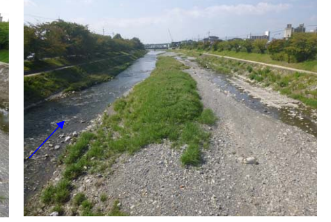
2014 年 9 月 22 日（施工後約 4 年 6 ヶ月） （H26 台風 11 号後 約 1 ヶ月）
