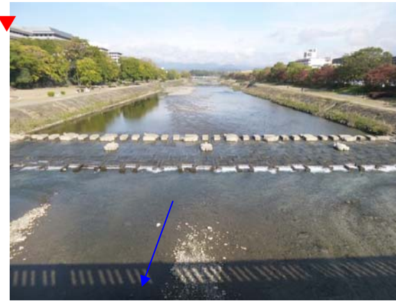
2013 年 11 月 14 日 （施工後 約 2 年 8 ヶ月・18 号出水後）
