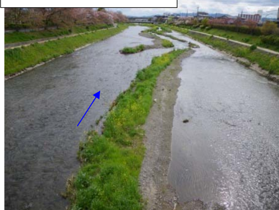
2010 年 4 月 16 日（施工直後）
