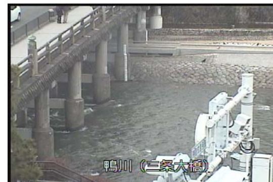
CCTVの画像(昼間)
