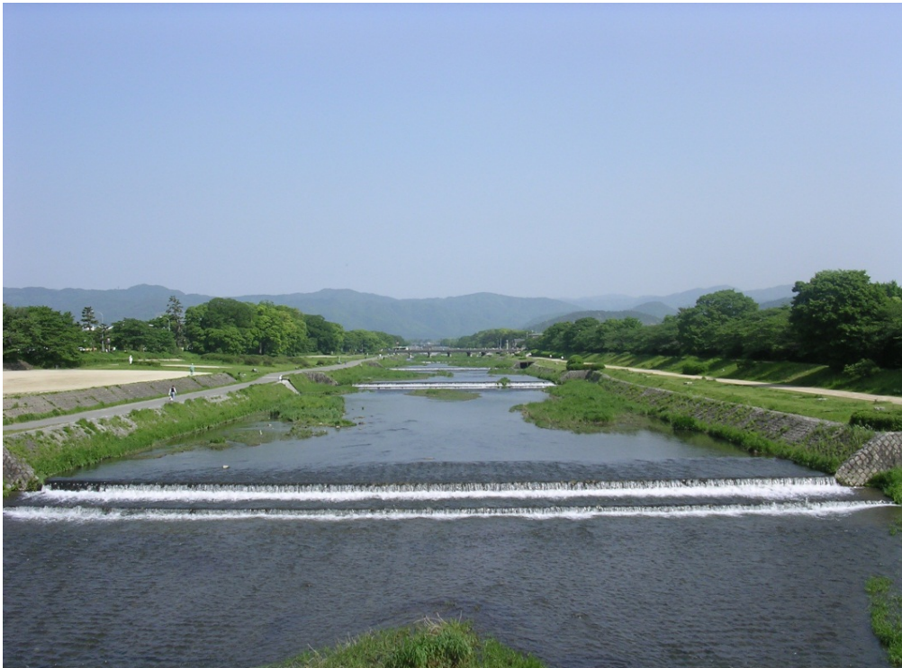
出雲路橋上流から望む落差工
