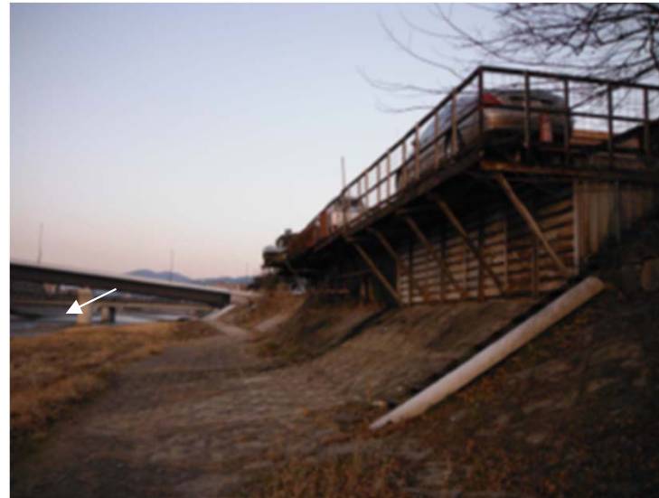
勧進橋上流左岸
