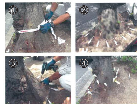
① 株元の周囲を測定 ② 10～15cm 間隔で薬剤を配置 ③ 直径6mm 程度の穴を50度の角度で6～7cmの深さにドリルで開ける ④ 薬剤を差込む。30分～2時間で終了
