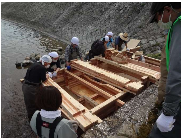
令和 3. 3. 27 三条魚道設置作業の様子
