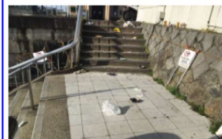
四条大橋右岸階段
