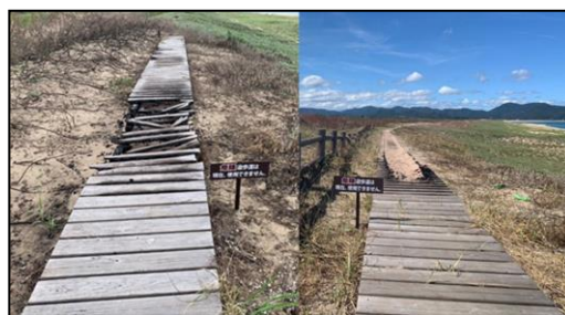
（遊歩道 現況写真）
