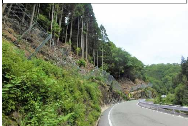
法面对策事業（枚方亀岡線）R7工事完了予定
