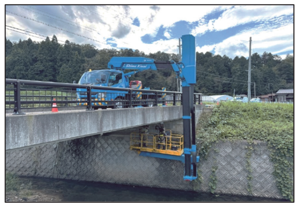
定期点検（橋梁点検）
