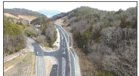
国道423号（法貴バイパス 亀岡市）
