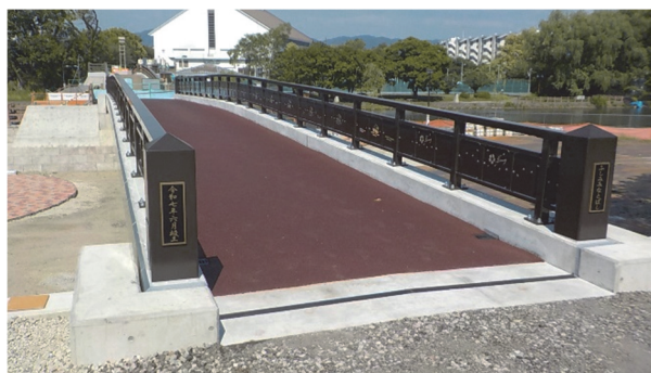
伏見みなと橋（延伸完了）
