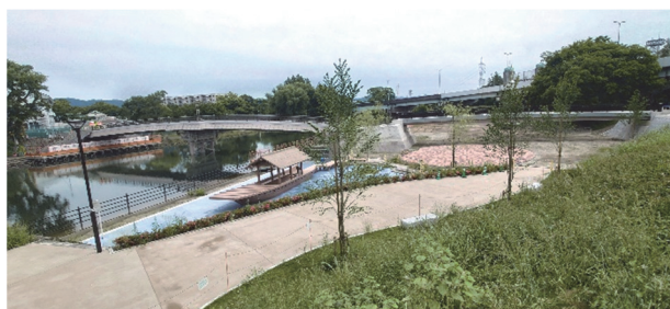
伏見みなと公園広場（完成部分）
