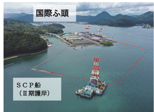
舞鶴国際ふ頭Ⅱ期整備
