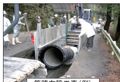
管路布設工事(例)
